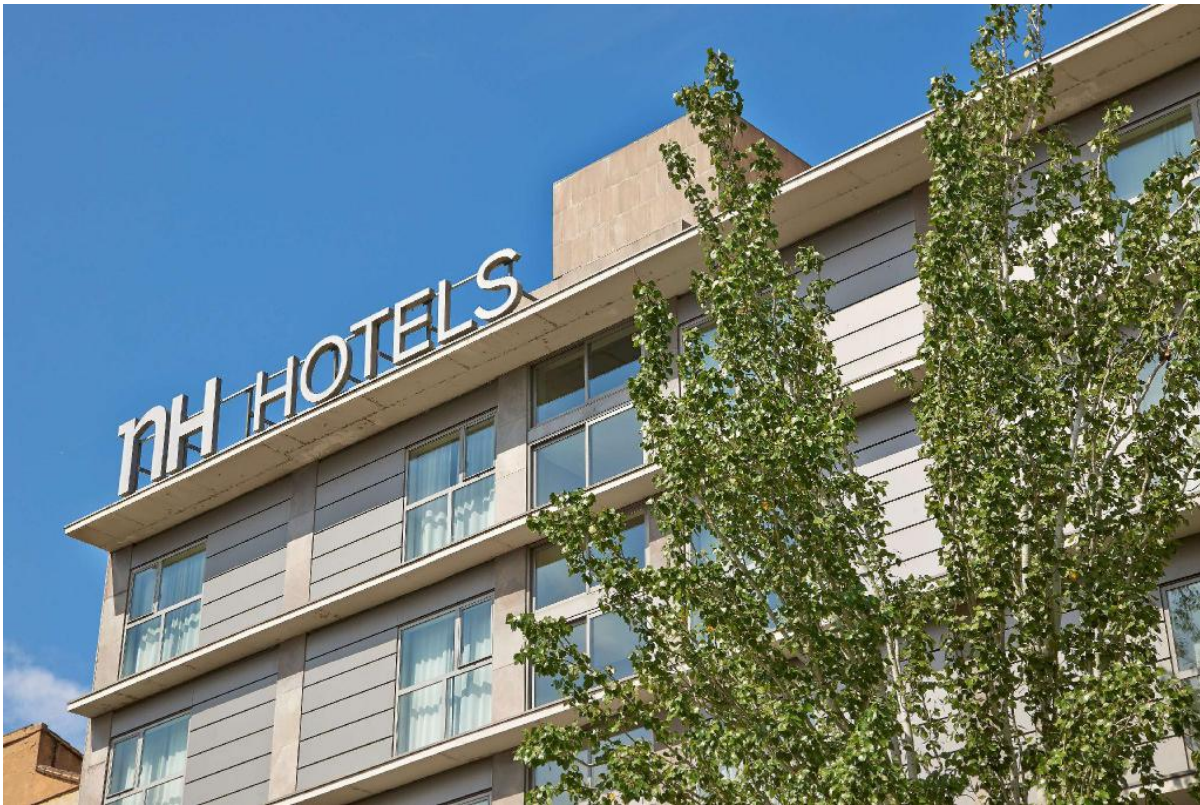
Hotel NH sito en Zaragoza (Foto: Agoda)
