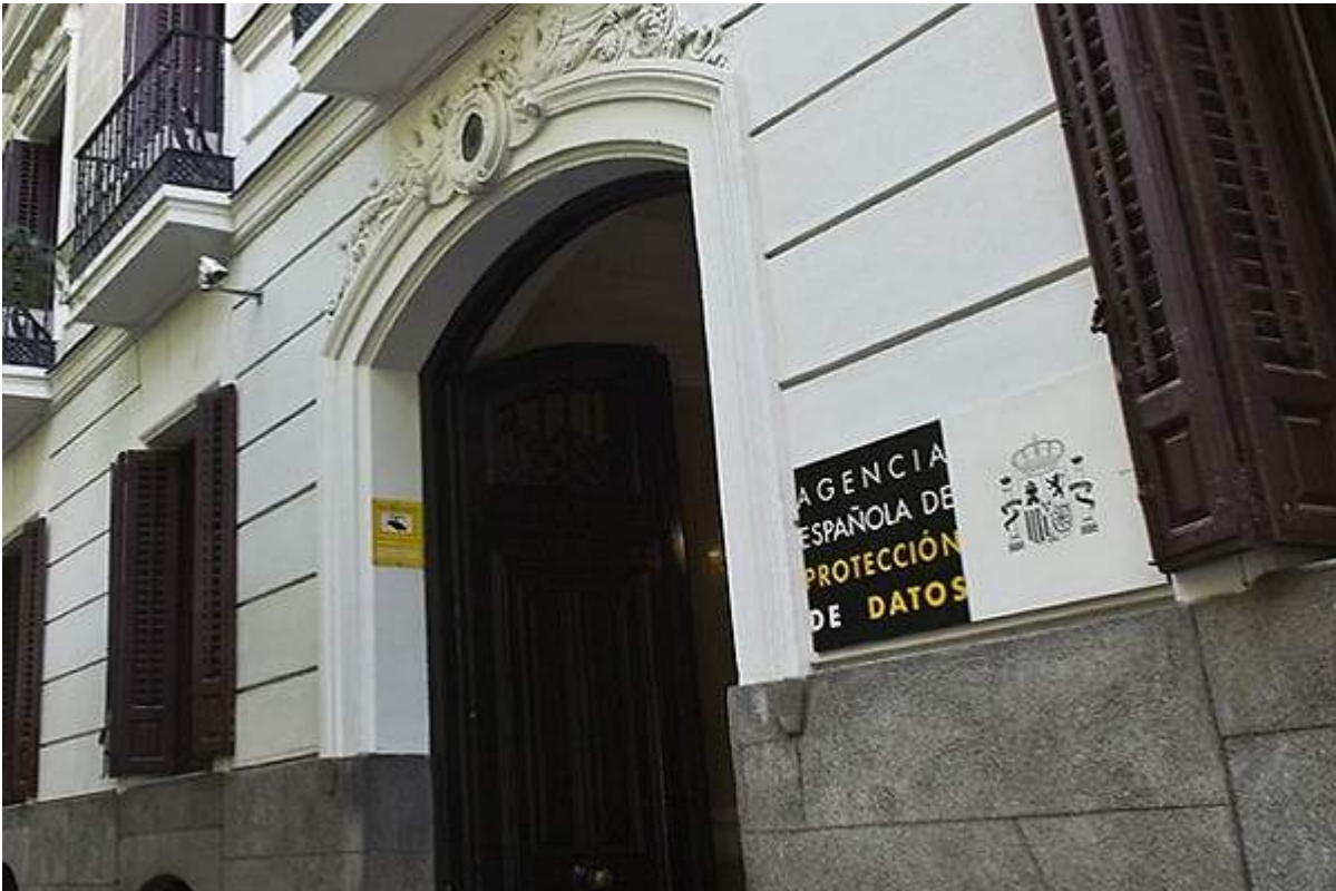
Fachada del edificio de la Agencia Española de Protección de Datos (Fuente: Twitter)
