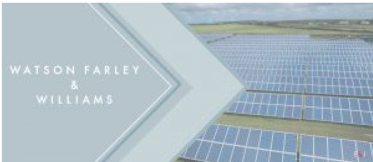
Planta fotovoltaica (Foto: WFW)
