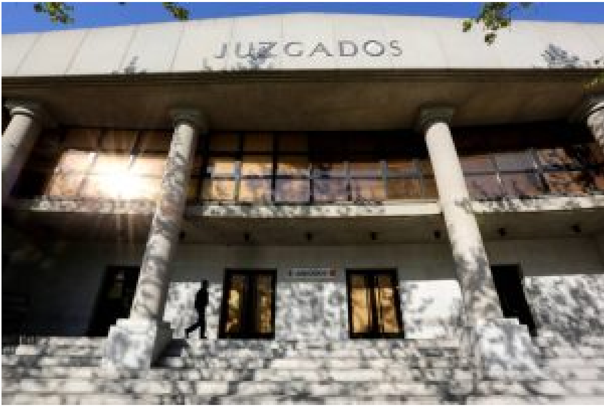
Fachada de los juzgados de Alcorcón (Foto: Víctor ...
